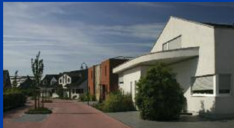
Nach der Fertigstellung
