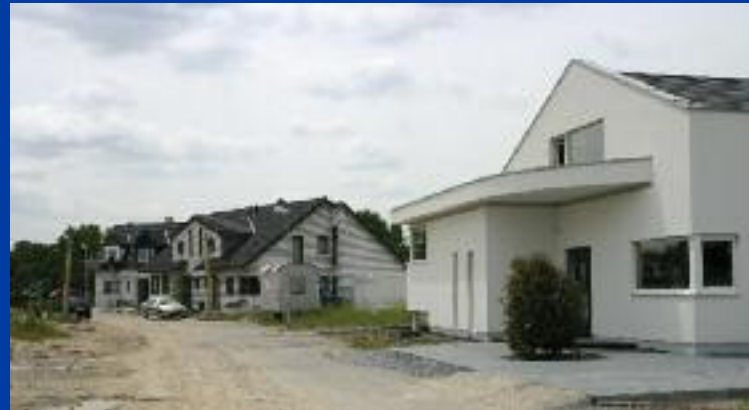
Vor der Fertigstellung
