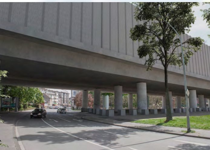
Meiderich, Auf dem Damm, Hochstraße.
